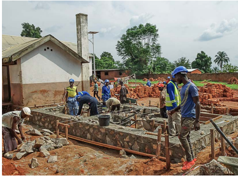
Erweiterung und Renovation am Spital Kapanga
